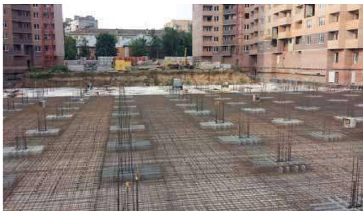
Рис. 1, б. Плитная сталежелезобетонная фундаментная плита
