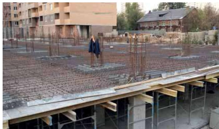
Рис. 2, б. Плитное сталежелезобетонное перекрытие
