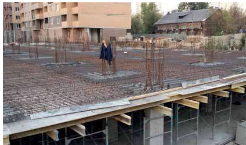
Рис. 2, б. Плитное сталежелезобетонное перекрытие
