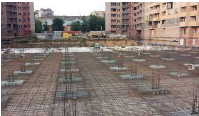
Рис. 1, б. Плитная сталежелезобетонная фундаментная плита
